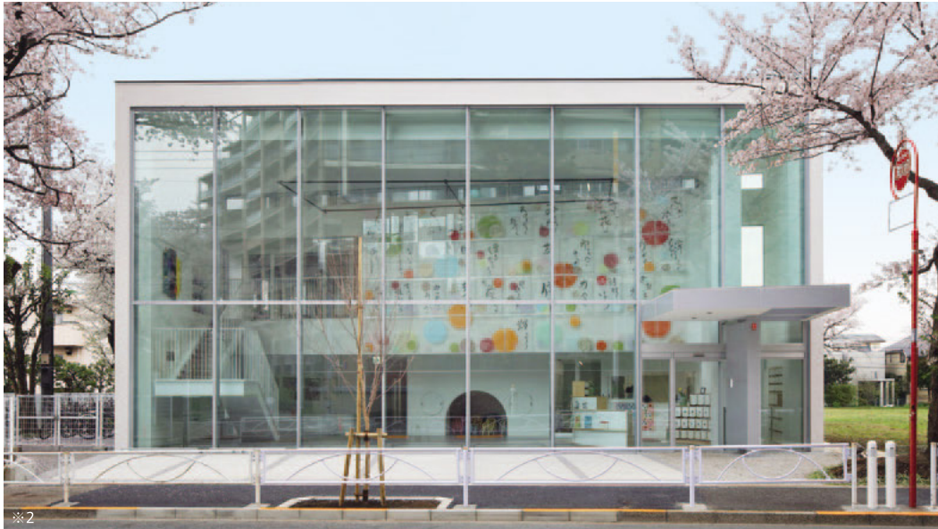
上：前面道路側に配置したガラス張りのランチルーム。 下左：ランチルームで食事を楽しむ園児の姿が通りをゆく人の微笑みを誘う。 下右：墨×白の洗練された色づかい。春には墨色の壁面が桜を引き立てる。
