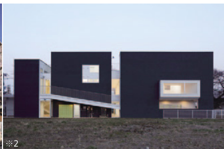
建物側面。左からランチルーム展示棟、事務管理棟、保育室棟の3つの棟から成る。
