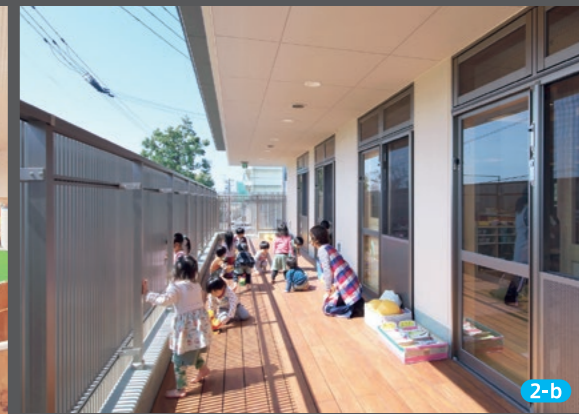
〈バルコニー〉 ルーバー手摺の採用で、安全性と風通しの良さを両立。低年齢児が日差しと海風を感じながら遊ぶことができる。避難用の屋外階段と直結
