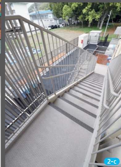
〈屋外階段〉 津波発生時の2階からの避難経路として設置。保育士が往復できるように、滑り台ではなく階段とした
