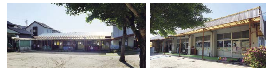
それぞれ築58年(左)と39年(右)が経過していた旧園舎。一体的な建て替えて保育環境の充実を図った。
