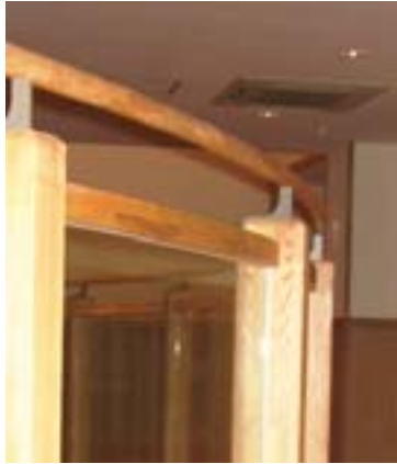
階下をのぞむ踊り場の手すりは、足がかり部分から120cmを確保することで、よじのぼりによる落下事故を防止。
