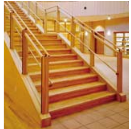
▲幅の広い階段の両側に手すりを設置し、踏みはずし等による転落事故を防止。
