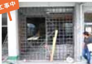
園舎の壁を部分的に補強工事。壁の中に鉄筋を組みこむことにより、耐震性能を高めています。柱と同様、見た目にはあまり変化はありませんが、安心感のある頑丈な壁に生まれ変わりました。
