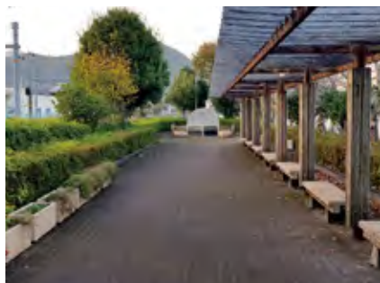
▲改修前公園全景
