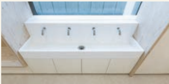
手洗い場の出っ張りなど途切れる要素をなくし、建築と一体化させている。
