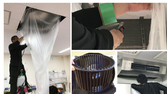
分解して特殊な洗剤を塗布後に高圧洗浄し、部品も別途洗浄
